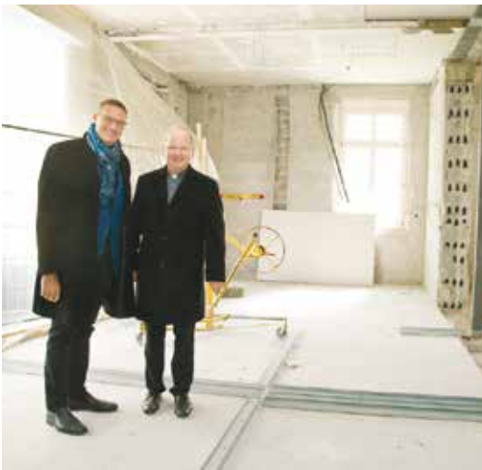
Rundum zufrieden: Landesrat Bernhard und Bischof Benno Elbs auf der Baustelle
